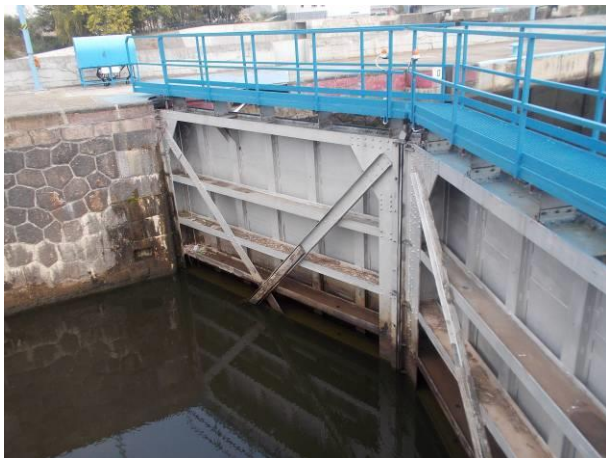
vzpěrná vrata DO z levého břehu
