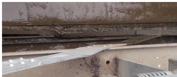
deformace diagonál levé vrátně HO
