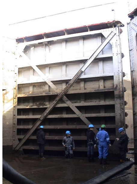
vzpěrná vrata DO, vyčerpaná PK (ještě s původní lávkou)
