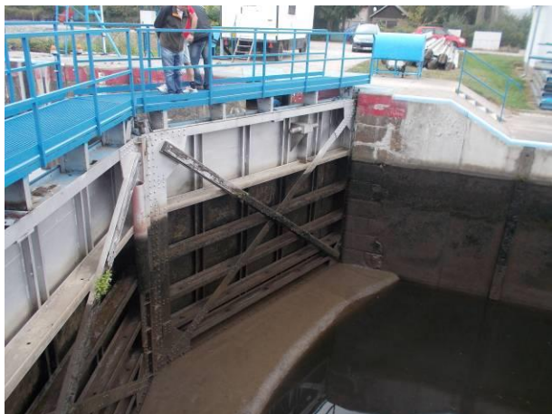
vzpěrná vrata HO z pravého břehu
